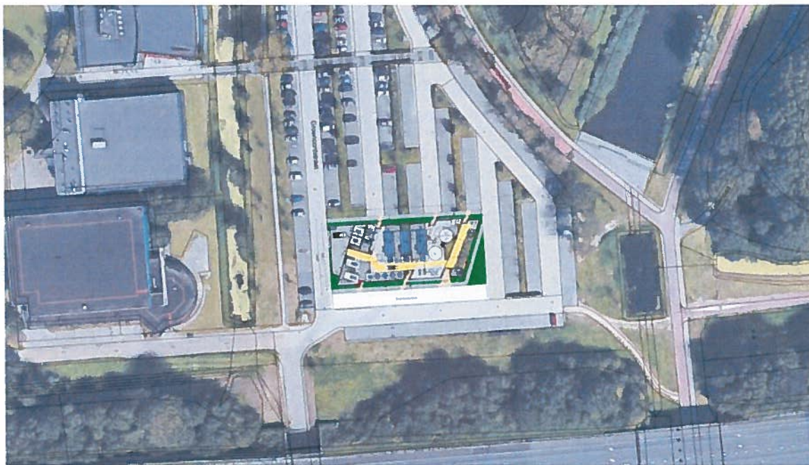
Figuur 1: Situering Warmtestation Groenord en toegangsweg
